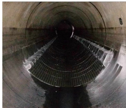
Abb. 6: Abwasserwärmetauscher im Kanal (Quelle: Fa. Uhrig)
